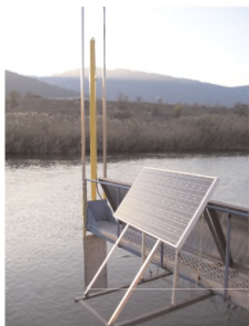
Φωτογραφία 4.8. Ηλιακό πάνελ παροχής ενέργειας για τη λειτουργία του πρότυπου συστήματος μέτρησης της παροχής στον Στρυμόνα.
